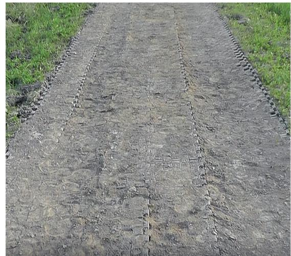
Hier wurden massive Kunststoffraster auf eine dünne Ausgleichsschicht direkt in den gewachsenen Boden gelegt und anschließend verfüllt (links). Nach acht Jahren sieht dieser Weg mit Kunststoffrastern immer noch gut aus. Er bleibt trocken, das Wasser sammelt sich an den Seiten (Mitte). Preiswerte Kunststoffraster verbiegen sich unter Umständen bei Belastung und bilden dann mit der Zeit Spurrillen (rechts). Fotos: Romanazzi
