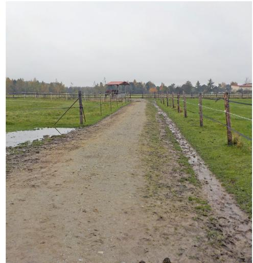
**Bodenbefestigung am Hang:** Der Boden wurde ausgekoffert und begradigt. Dann wurden eine Tragschicht aus Recycling-Schotter, eine Trennschicht aus Vlies und eine Trettschicht aus feinerem Schotter aufgebracht (links). Ein neu angelegter Schotterweg in der Ebene (Mitte) sieht nach acht Jahren aus wie auf dem rechten Bild.
